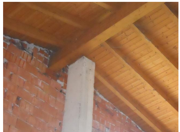
Immagine 3.10: copertura in legno lamellare
