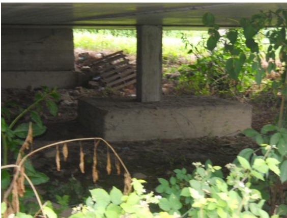
Immagine 3.3: plinto di fondazione in c.a.
