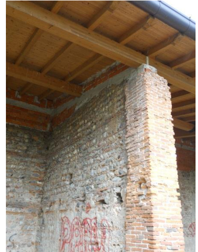
Immagine 3.6: pilastro in laterizio pieno
