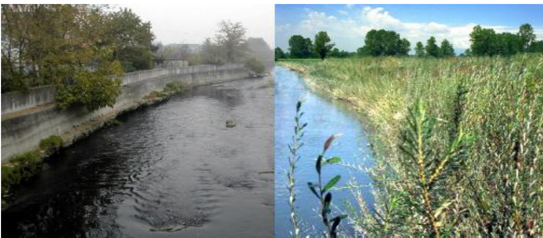
Immagine 2.3: esempio di intervento sulle sponde del fiume a Nerviano
