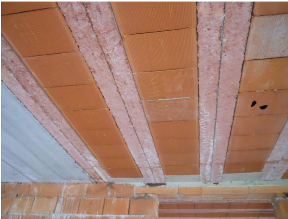
Immagine 3.7: solaio latero-cemento con elementi prefabbricati
