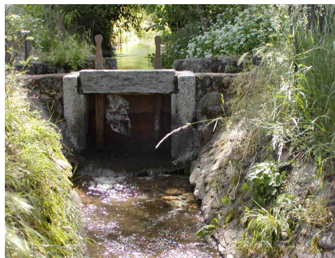
Fig. 7 – Roggia all'interno del Parco
