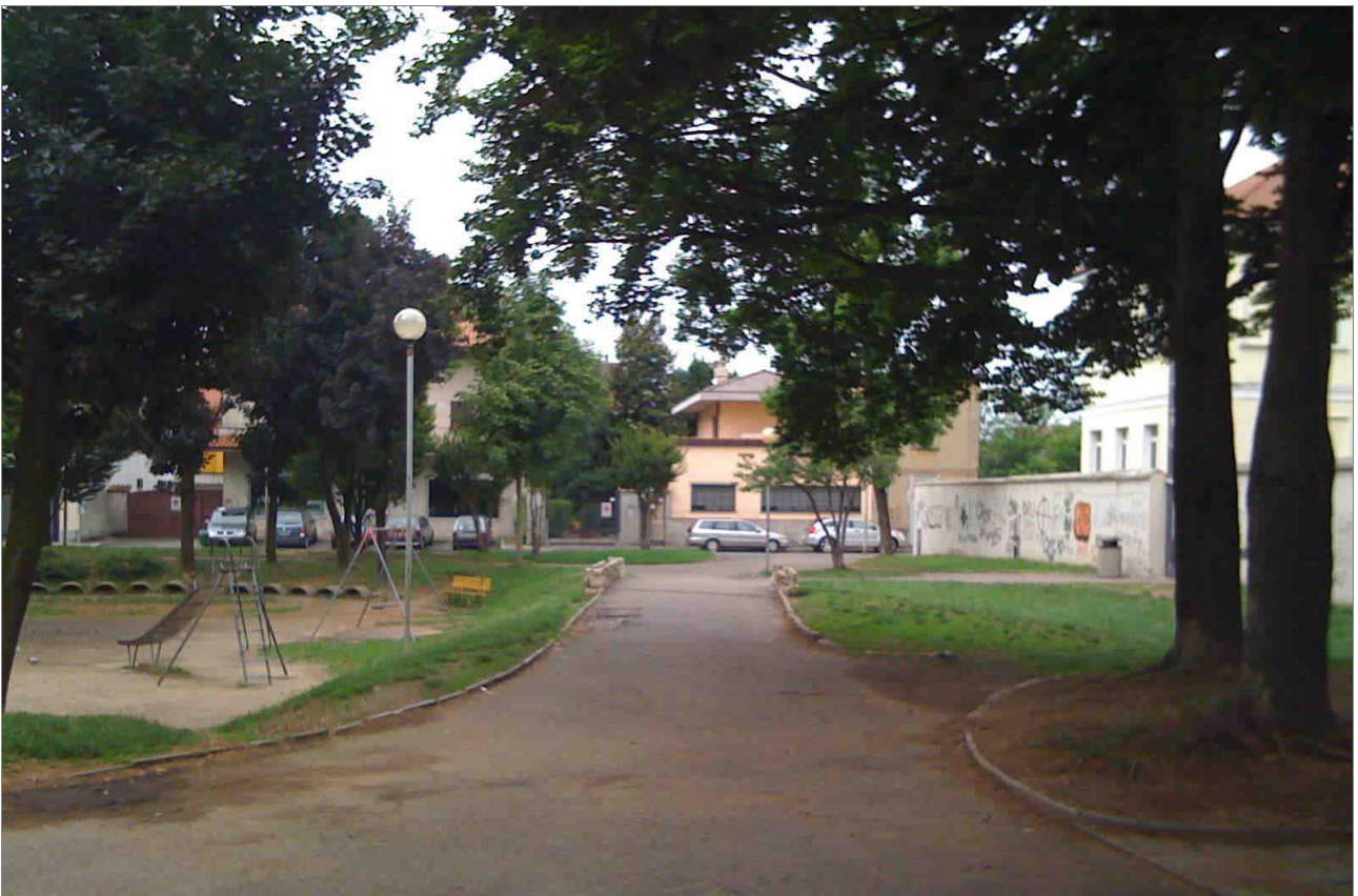
Anno 2011 - I vialetti del parco sono gravemente usurati.
