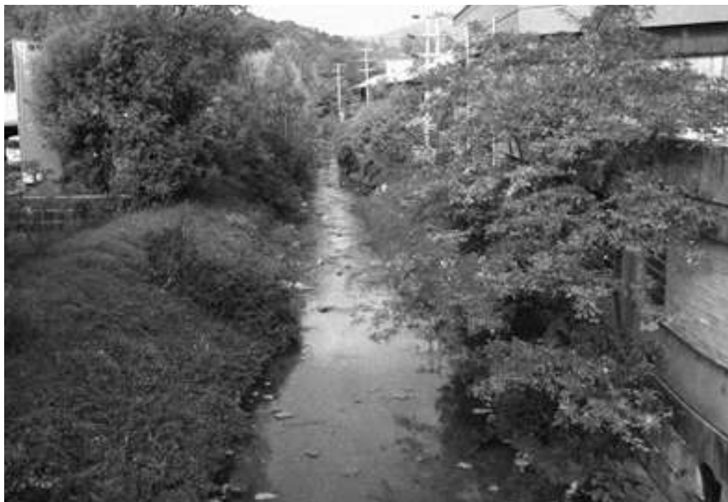
Varese: dal ponte di via Vanetti, lato nord.
