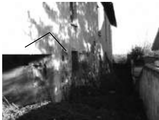
Al mulino Besozzi è rimasta la traccia della roggia molinara; la freccia indica dove si trovava la copertura della ponticella dalla quale si manovravano gli impianti esterni.
