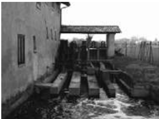
Gli impianti esterni del mulino Piazza o Star qua, manca una ruota.
