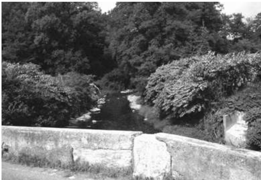
In alto e in basso: Varese, il ponte di via Friuli, visto da nord.
