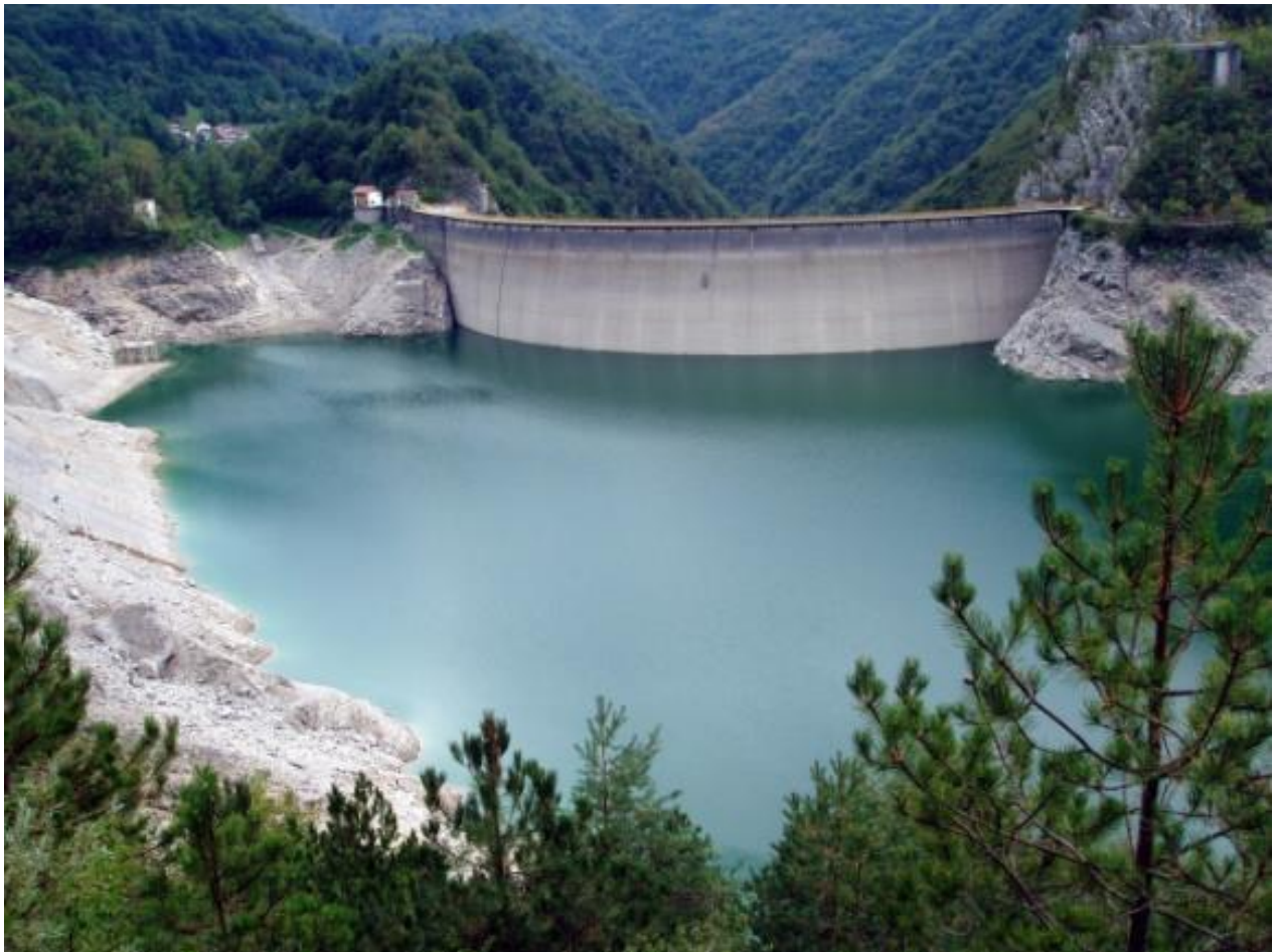
Figura 10: Tutte le acque del Torrente Meduna sbarrate a valle della centrale di Meduno, dalla Traversa di Ponte Maraldi e convogliate poi nella centrale di Colle (portata media utilizzata 12,7 mc/s, 4 MW, 9,7 GWh).
