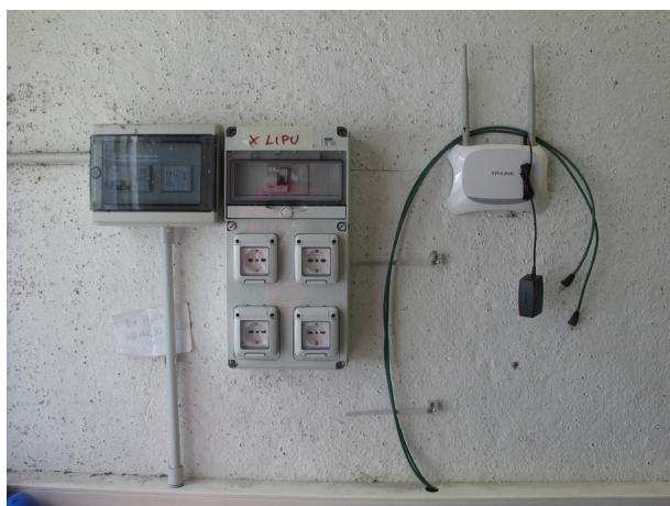
Una fase dell'allestimento
