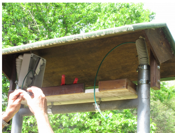
Montaggio della telecamera
