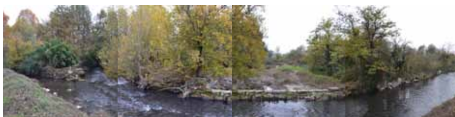
I manufatti esistenti
