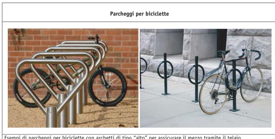
È di fondamentale importanza, al fine di garantire un maggior grado di sicurezza contro i furti, che ogni punto di sosta sia costituito da archetti o sostegni di tipo "alto", cioè in grado di assicurare la bicicletta tramite il telaio e non, come spesso accade con le rastrelliere in uso, tramite la ruota.
